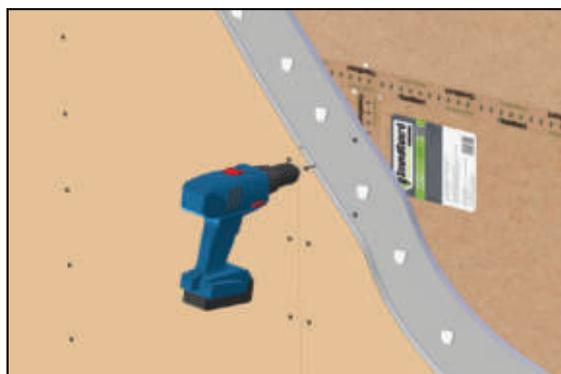
**10** В звукоизоляционных каркасно-обшивных конструкциях гнёзда для розеток, выключателей и точечных светильников помещают в короб **SoundGuard IzoBox**.
