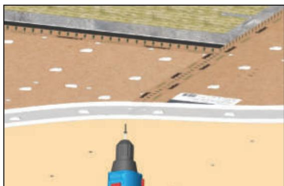
Для работ вам потребуются звукоизоляционные панели **SoundGuard**, демпферная подложка **SoundGuard Roll** или мягкая ДВП толщиной 10–12 мм, герметик **SoundGuard Seal**, самоклеющаяся лента **SoundGuard Tape**, напольное покрытие из ламината или паркетной доски системы **Click**.
