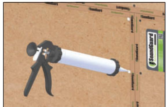
**7** Места стыков панелей между собой и швы при закрытия к полу, стенам и потолку при помощи шпателя или монтажного пистолета заполняются герметиком **SoundGuard Seal**, желательно не ранее, чем через 24 часа после монтажа, и проклеиваются самоклеющейся лентой **SoundGuard Tape**.
