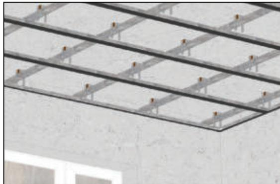
**5** После монтажа каркаса из направляющих профилей удаляются дюбель-гвозди.
