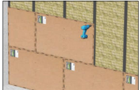
**6** Шляпка самореза слегка утапливается и изолируется от прямого соприкосновения с облицовочным гипсокартонным листом с помощью герметика **SoundGuard Seal**.
